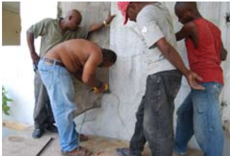
• L'opération de dépose du bas-relief
